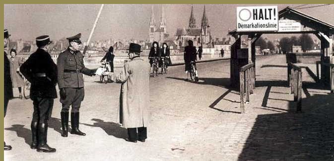
Ligne de démarcation au pont Régemortes à Moulins
