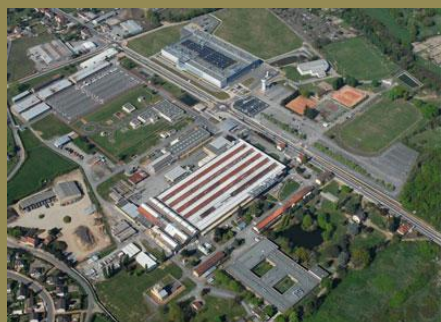
Usine Sagem-Groupes Safran à Montluçon
